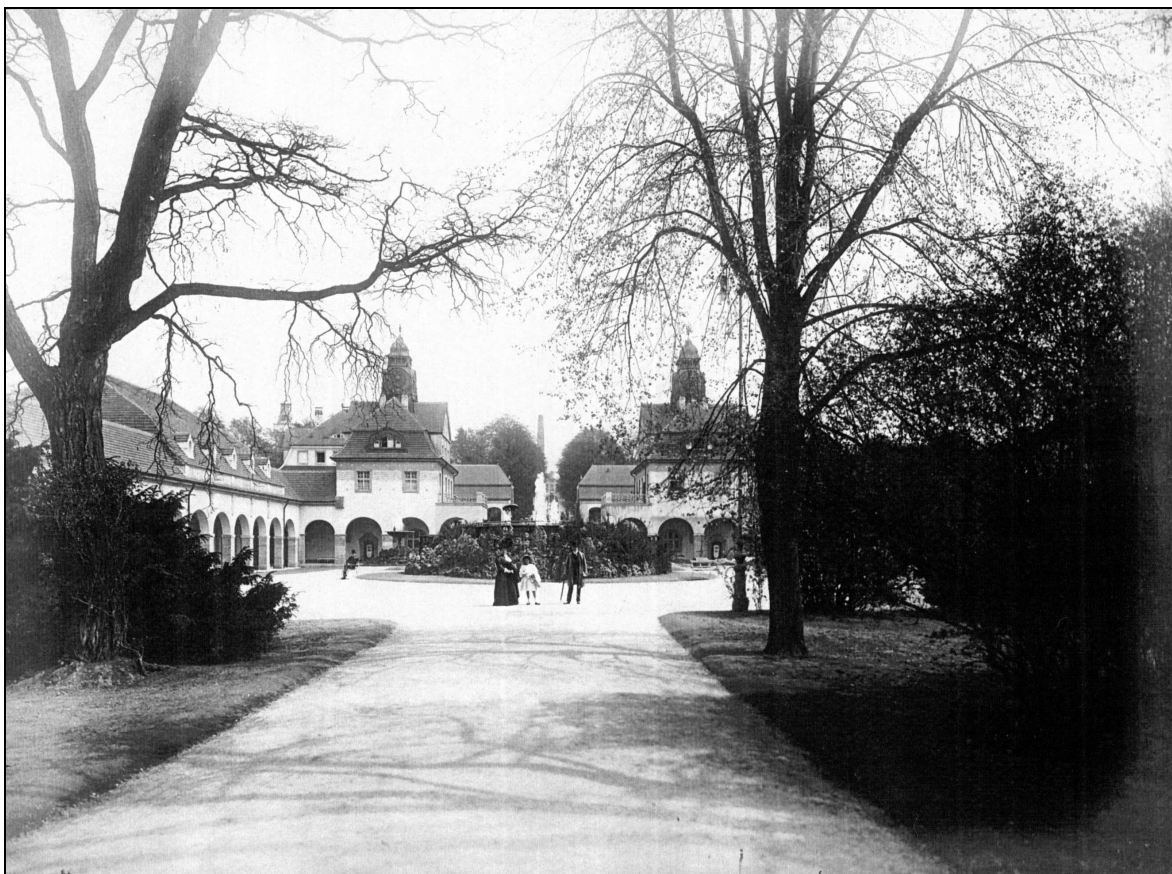
Abb. 7: Der Sprudelhof, 1909/10, mit der alten Sprudelfassung aus Gradiergestein; Foto von A. Schmidt, freundlich überlassen von Chris Nees.
